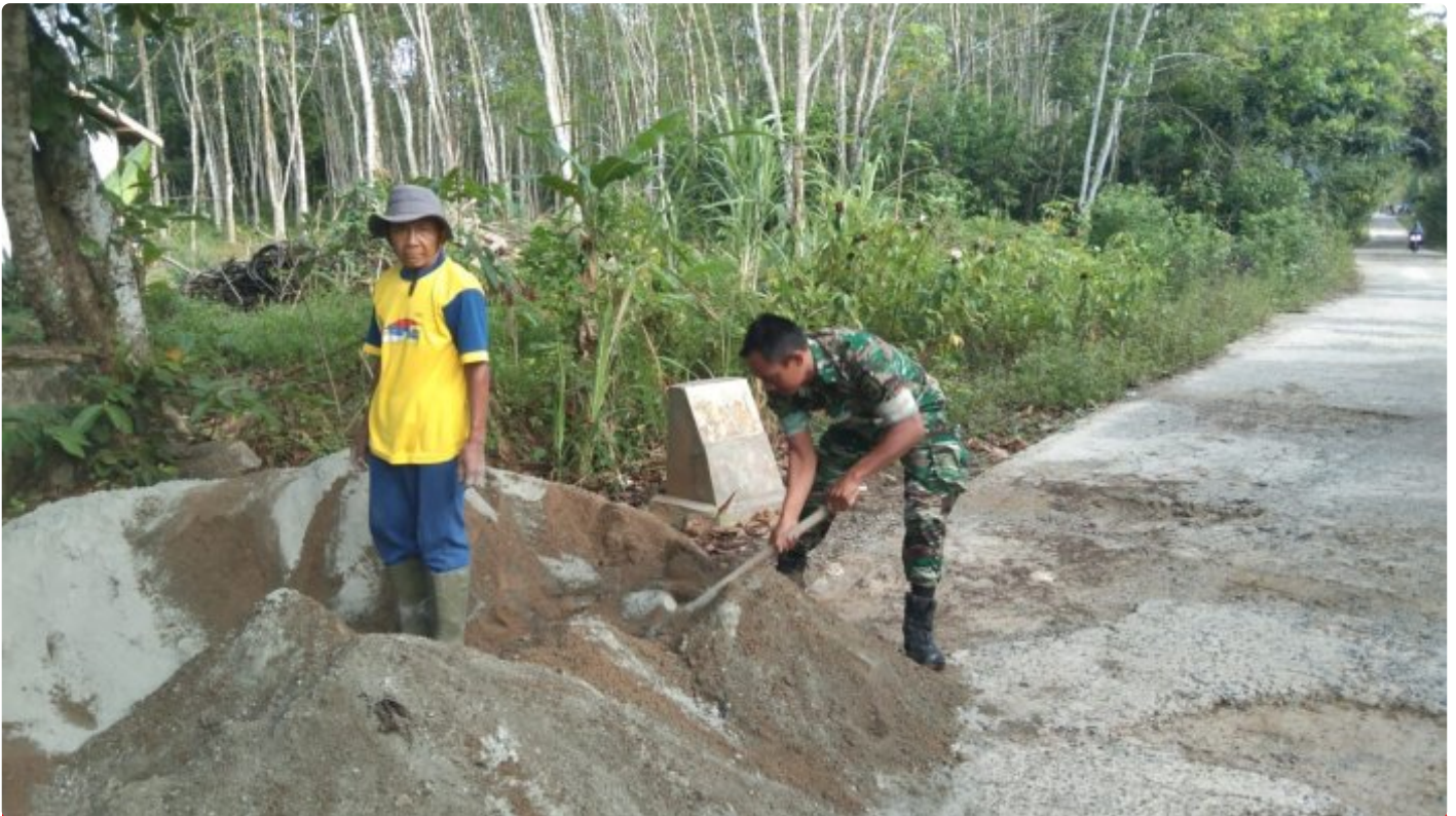
Babinsa Bantu Gotong Royong Pengecoran Jalan
